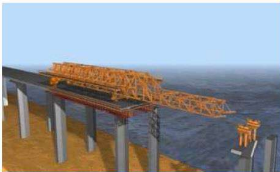
Figura 2: Treliça tridimensional com carrinho de avanço.
