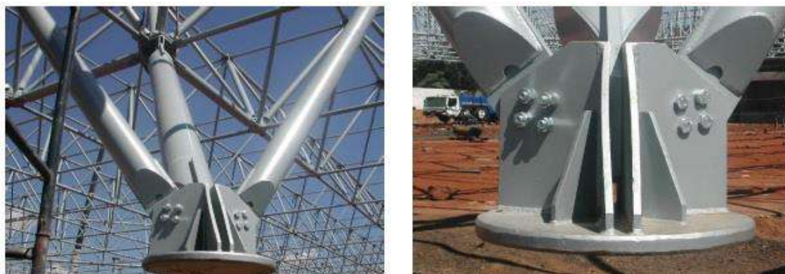
Figura 9: Detalhe do Nó de Aço - Expominas - Belo Horizonte - MG
